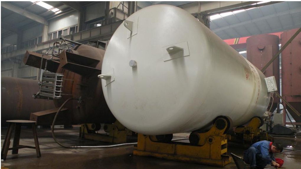
图 1：核电站压力容器焊接
