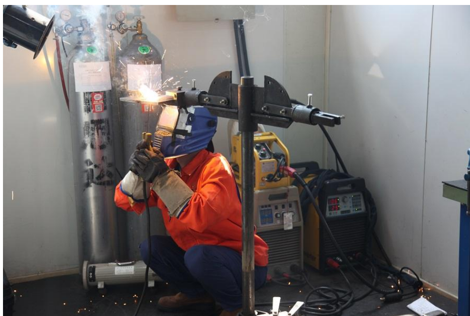
图 4：仰焊实际操作
